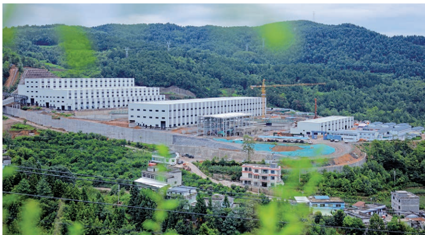
赫章鼎盛鑫猪拱塘铅锌矿项目全景
