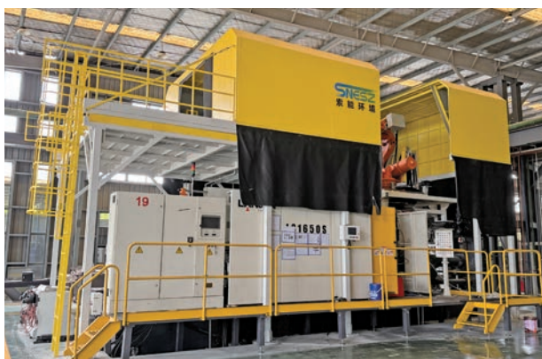
路飞镁业冷室 1650T 高压精密压铸机作业现场
