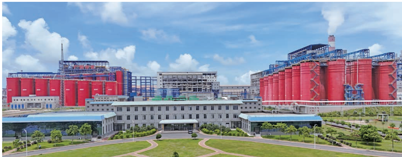
2025年，广西华昇氧化铝项目二期竣工
