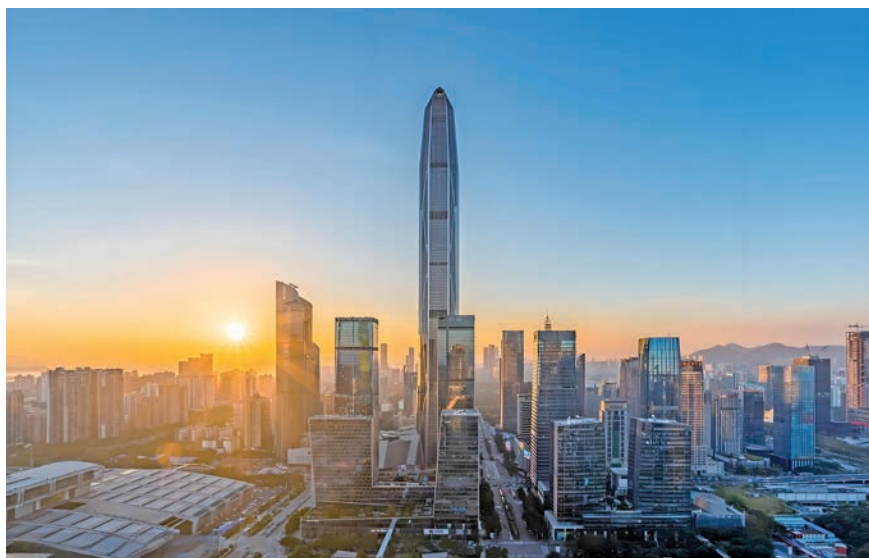
中勘院完成中国第二高楼——深圳平安国际金融中心岩土工程勘察
