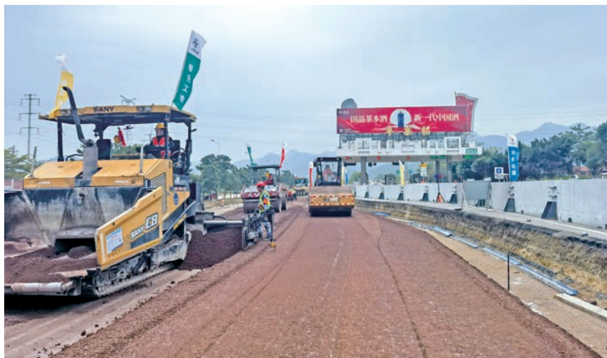
高速公路用赤泥基层施工现场
