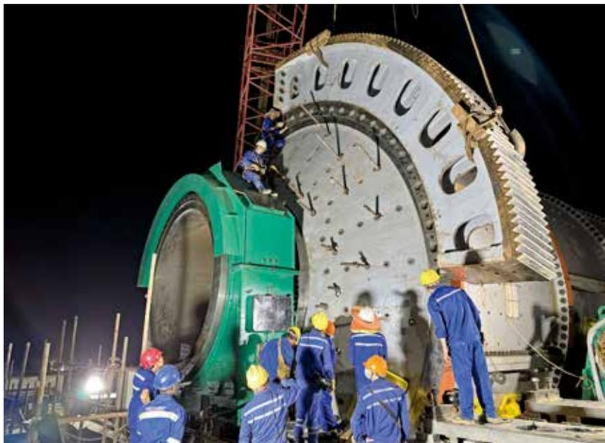
安装人员进行球磨机大齿轮吊装
