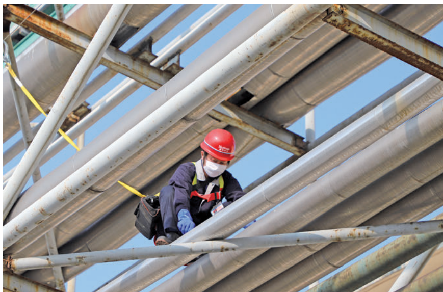
员工在维修管道
