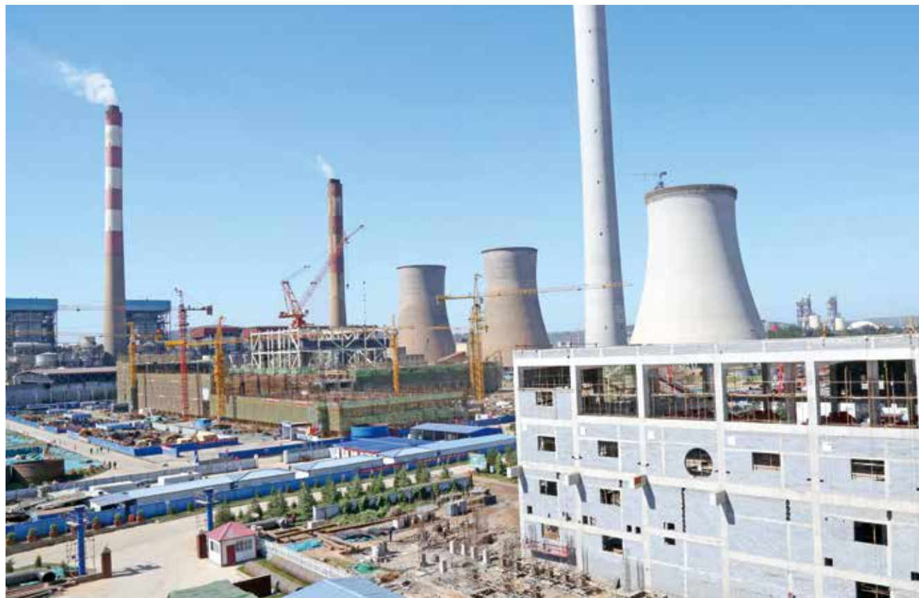
万基控股集团 2 \times 60 万千瓦机组建设工地
