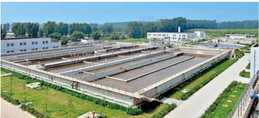
北京市房山区良乡污水处理厂二期
