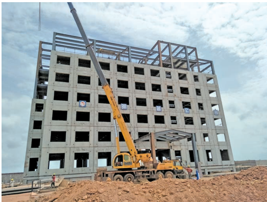
正在建设的赢联盟指挥中心大楼
